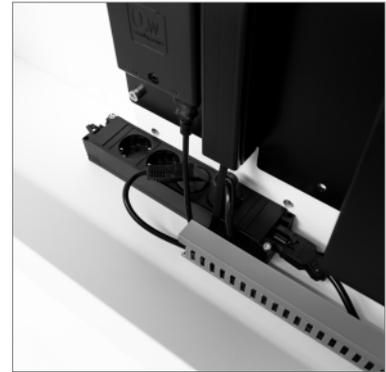
Abb. 3 Mehrfach Steckdosenleiste
